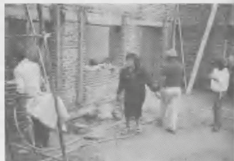
Los hermanos de Punta Alta trabajan con esmero en la construcción del templo.
